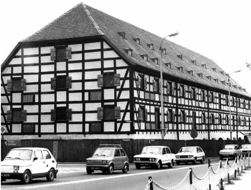
Der Speicher nach der Renovierung, der am elften November 1988 zum Gebrauch überlassen wurde.
