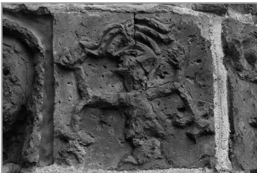
Fot. 24: Drawsko Pomorskie, portal południowy, gorgona Fot. 24: Drawsko Pomorskie (Dramburg), Südportal, Gorgo
