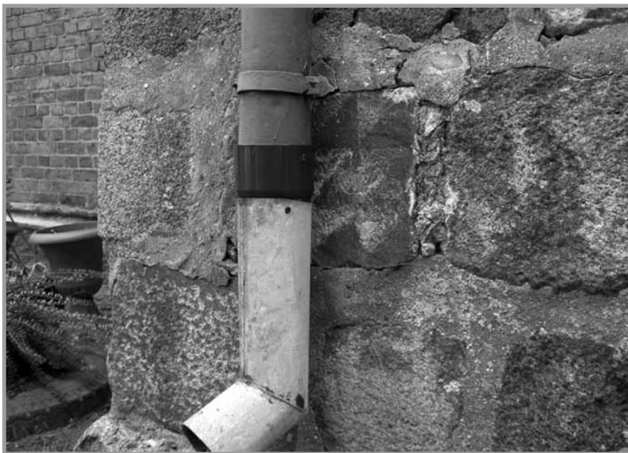
Fot. 46: Godków, południowa ściana kościoła, kwadra z szachownicą
