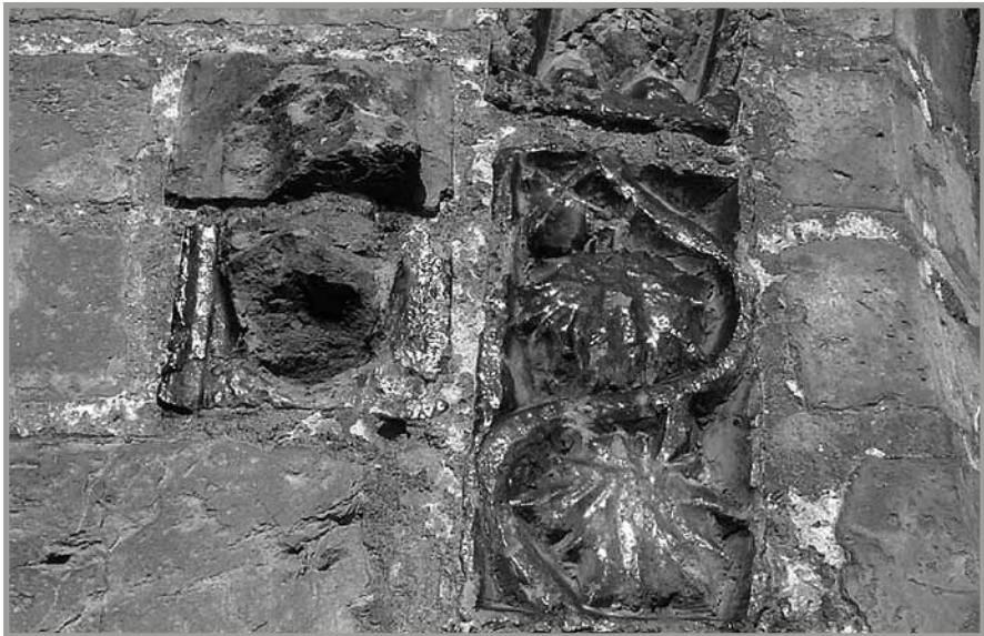
Fot. 13: Dobiegnew, portal południowy, chleb I (?)
